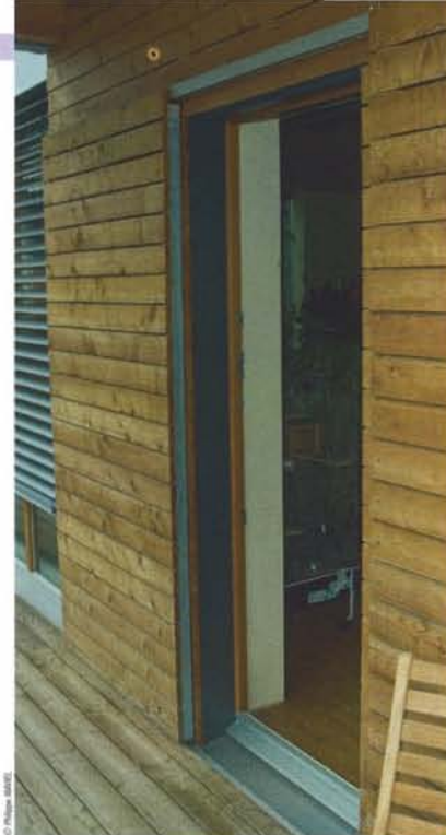
▲ L'entrebâillement de la porte laisse apparaître l'épaisseur des murs.
