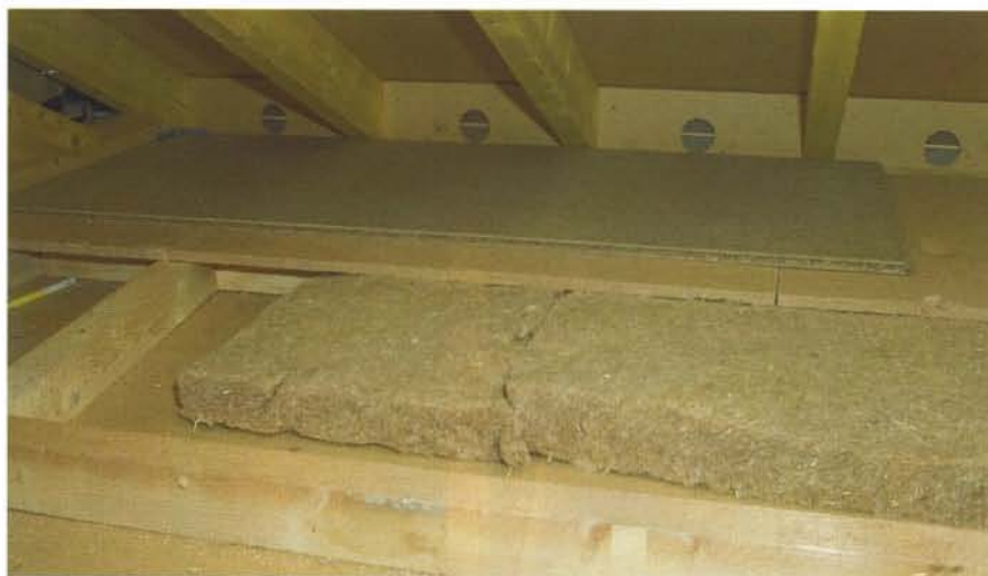
Pour la toiture, après la pose des caissons autoportants remplis de ouate de cellulose, l'isolation est complétée ▲ par une couche de laine de chanvre, sur laquelle se pose des panneaux de fibre de bois et d'aggloméré.
