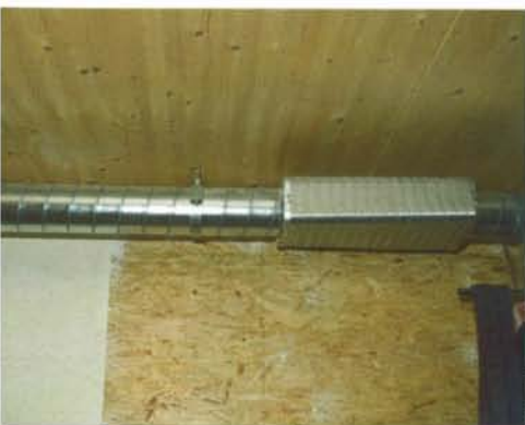
Les gaines d'insufflation de l'air ▲ sont munies de silencieux filtrants.
