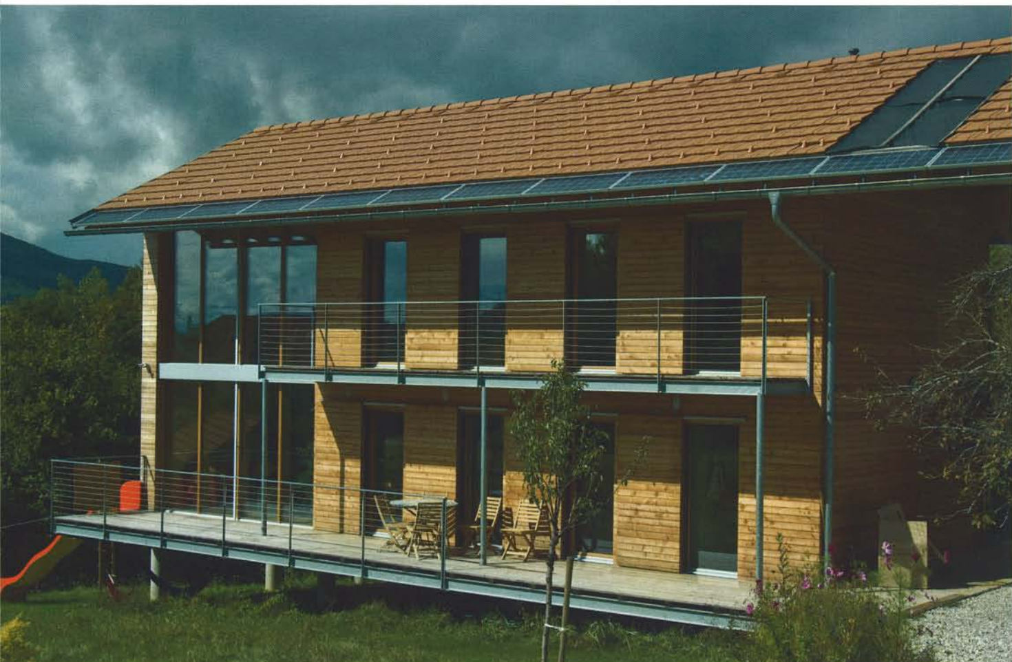
▲ La maison pour bénéficier d'un maximum de soleil est montée sur pilotis, plutôt que d'être encastrée dans le relief.
